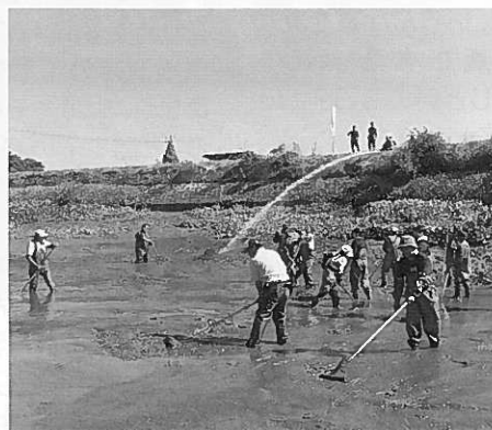
泥を掘り返しているところ
